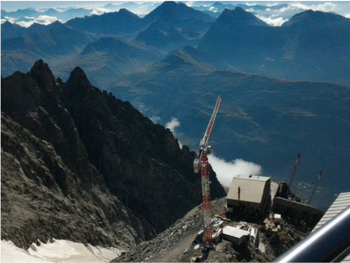
(Il cantiere ancora attivo presso il Rifugio Torino)
